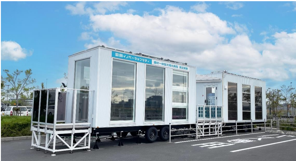
「羽田 建材一体型太陽光発電実証実験ラボ」全景
