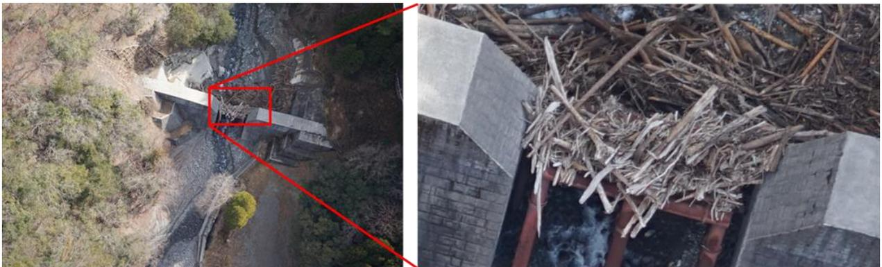
エアロボウイングが飛行中に撮影した砂防堰堤の画像（左）と拡大画像（右）
