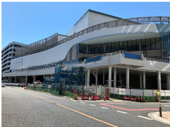
エミテラス所沢外観（2024 年 4 月 10 日撮影）
